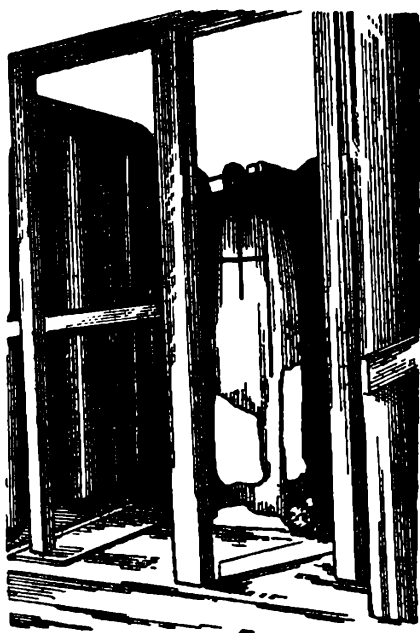
Рис. 2.40. Колонна склада с пустотами, разрушенная во время испытания
