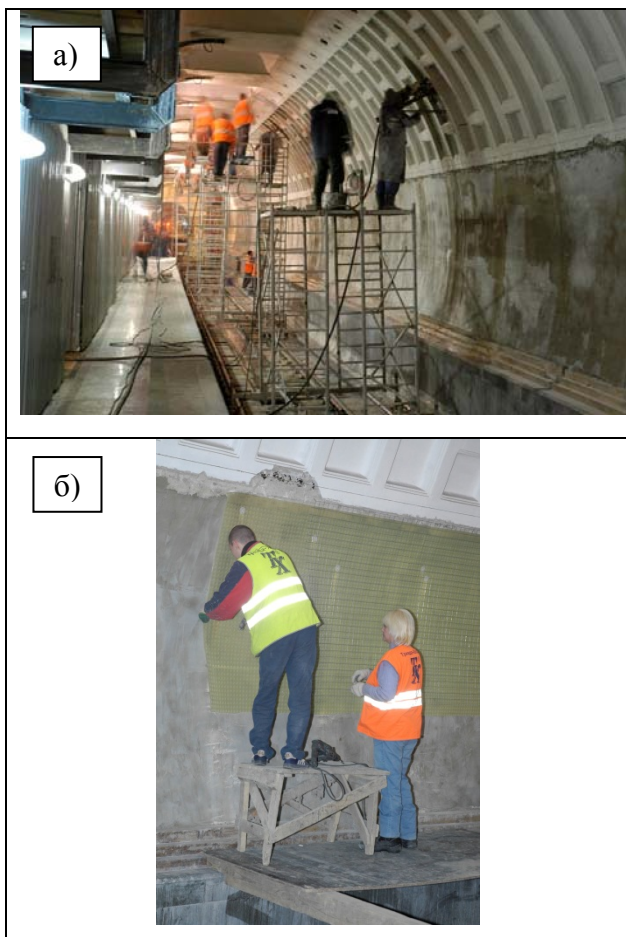
Рис. 11. Работы по герметизации путевого тоннеля (а), монтаж дренажного полотна к стене путевого тоннеля
