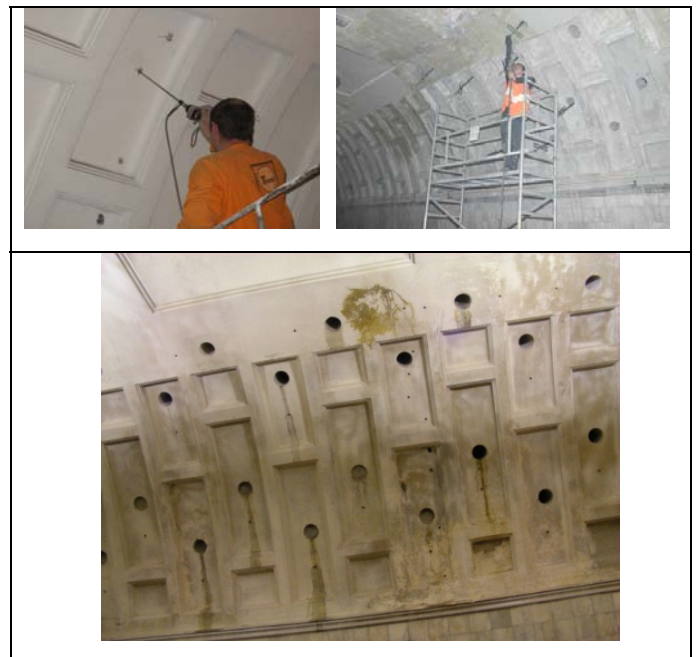
Рис.7 Технология корректировки расположения тампонажных отверстий в тубингах
