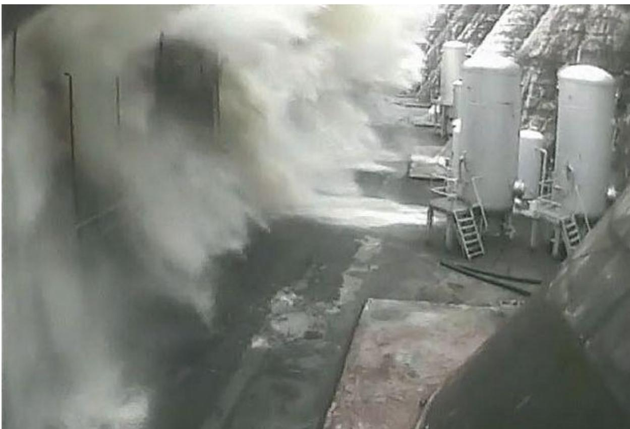
Рис.4. Поток воды, извергающейся из кратера второго гидроагрегата СШ ГЭС
