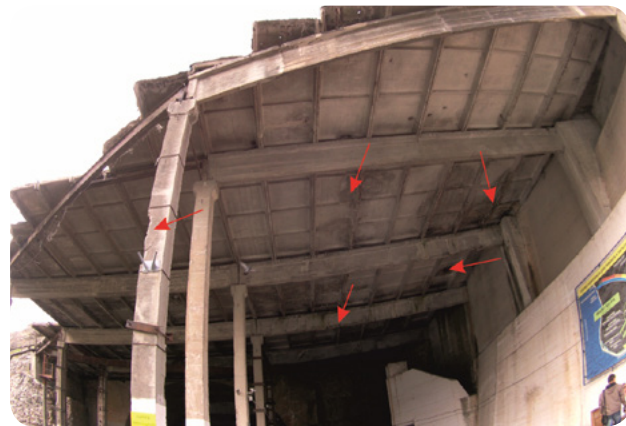
Рис. 1. Общий вид козырька над входом. Повреждения и дефекты, вызванные протечками кровли (откол защитного слоя бетона, коррозия арматуры и металлоконструкций), механическими воздействиями (отколы бетона, трещины)
