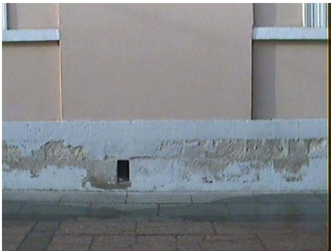
Рис. 2. Фасад Храма свт. Николая в Толмачах (при Третьяковской галерее) – простая и тепловизионная фотографии. Капиллярное поднятие влаги по цокольной части церкви
