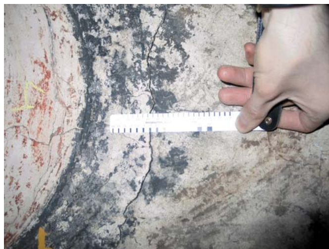
Рис. 1. Общий вид Благовещенского собора Московского Кремля. Одна из трещин, выходящая на поверхность Центрального барабана
