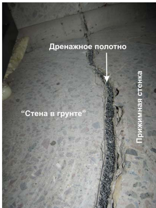
Рис. 2. Факторы, снижающие надежность защиты от грунтовых вод: неровная поверхность «стены в грунте», раздробленный, расслоившийся бетон, неправильный монтаж дренажного полотна
